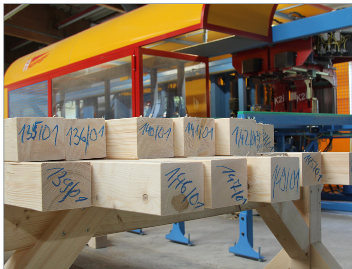
Die Hölzer werden passgenau vorbereitet, markiert und beschriftet
